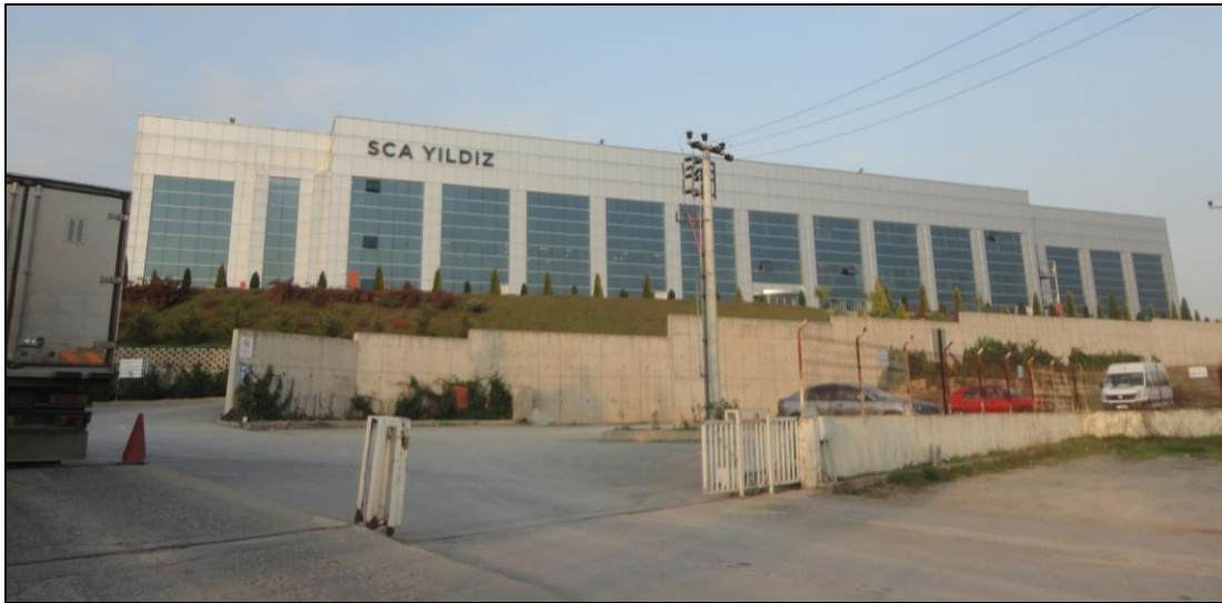
-Taşınmazın güney cepheden görünüşü-
