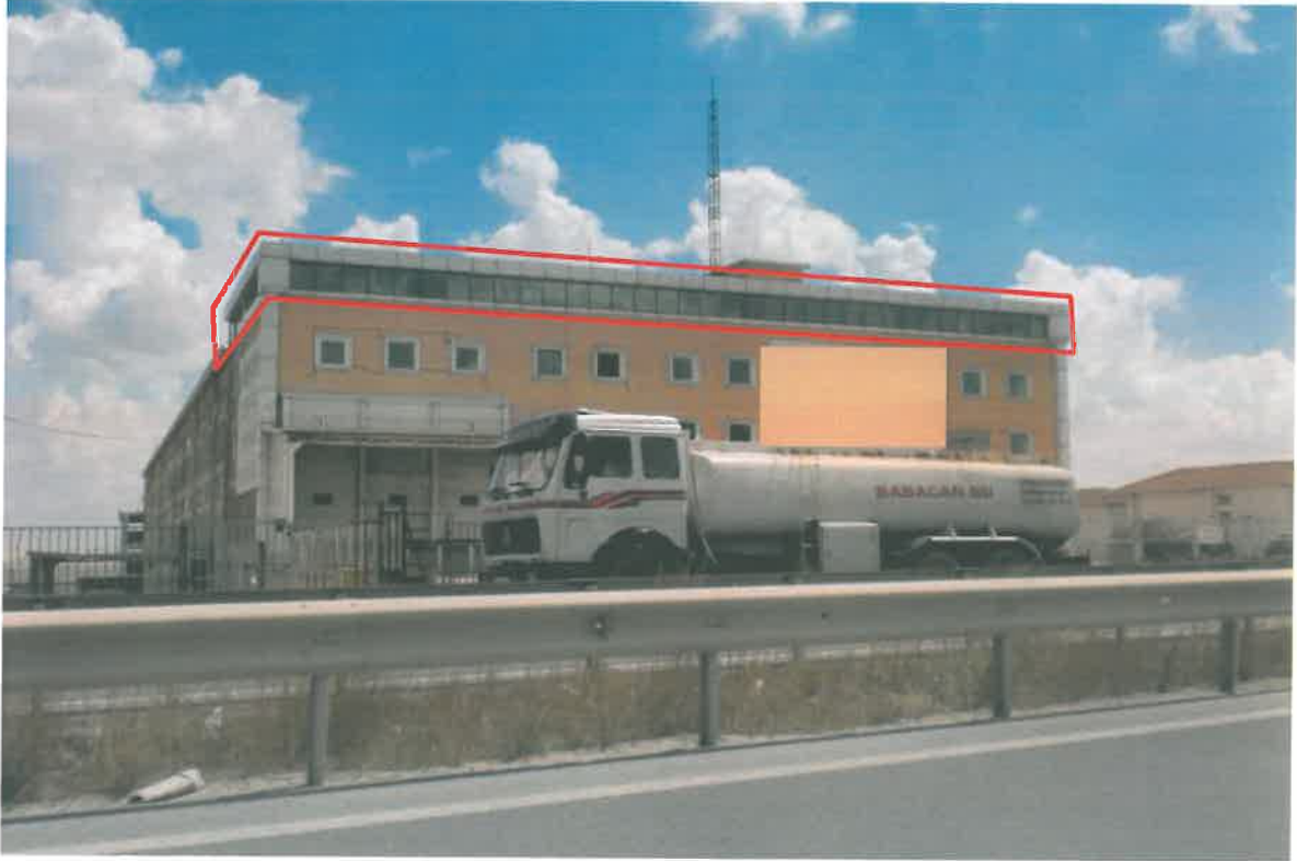
İdari Bina Proje Hilafı İnşa Edilen Kat
