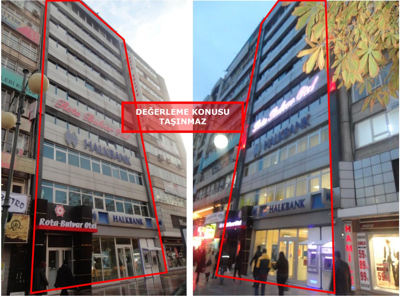
Bina Dış Görünüşü
