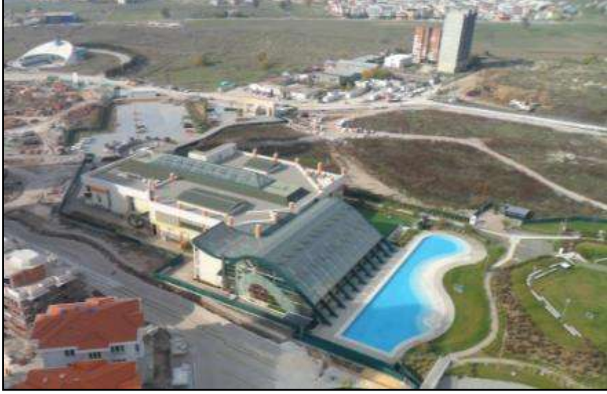
-301 Ada 16 Parsel Sosyal Tesis Görünüm-
