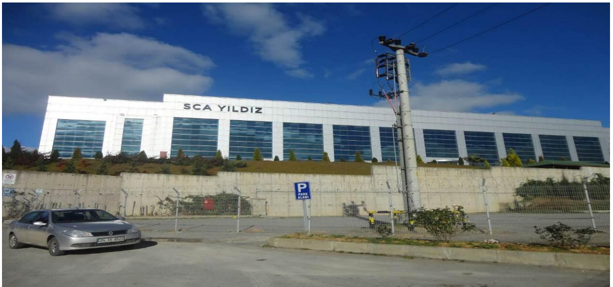
-Taşınmazın güney cepheden görünüşü-
