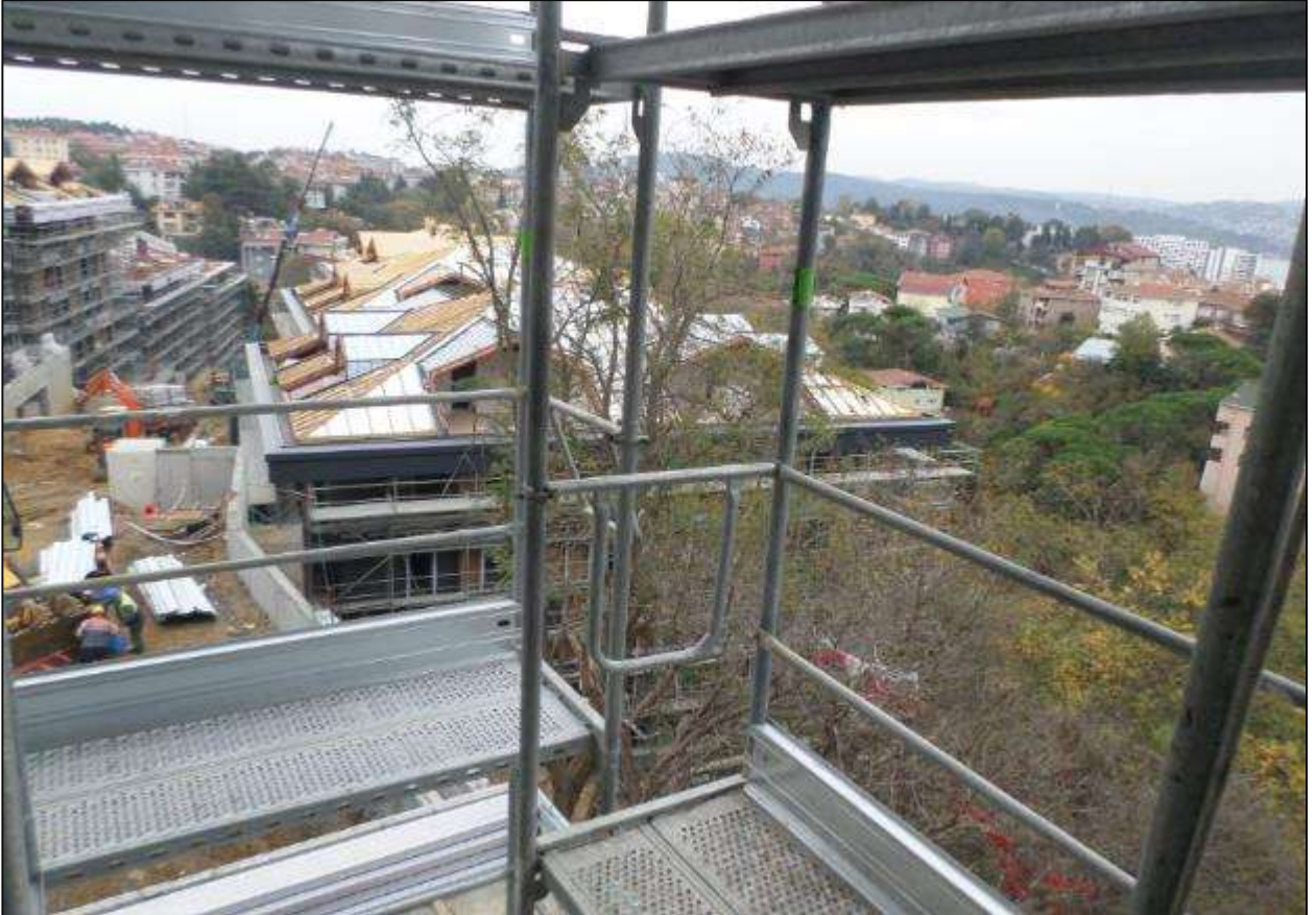
-82 parsel A, B ve C Blok İnşaatı-
