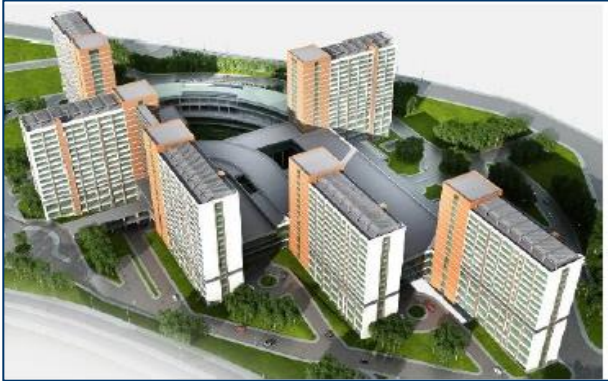
Şanlıurfa Sağlık Yerleşkesi (Şanlıurfa)
