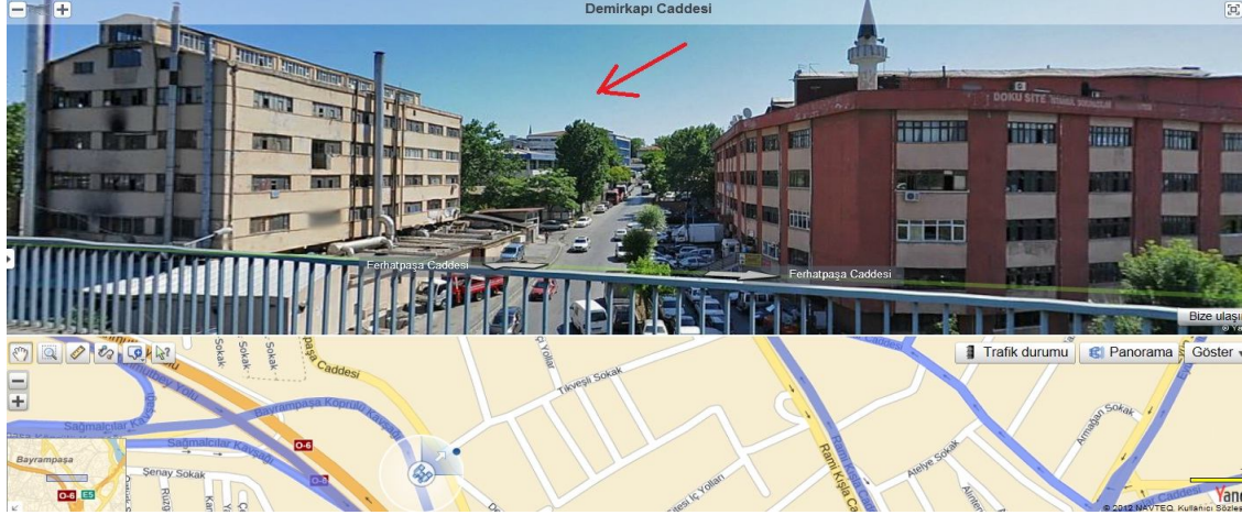
Kroki-5: Taşınmazın Konumu ve Cephe Aldığı Tikveşli Sokak'tan Görünümü
