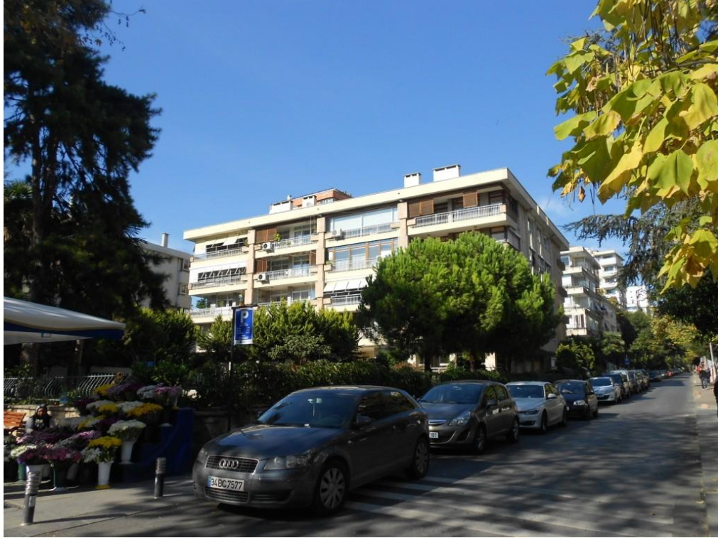
Erenköy Apartmanı'nın görünümü (Bağdat Caddesi cephesi)
