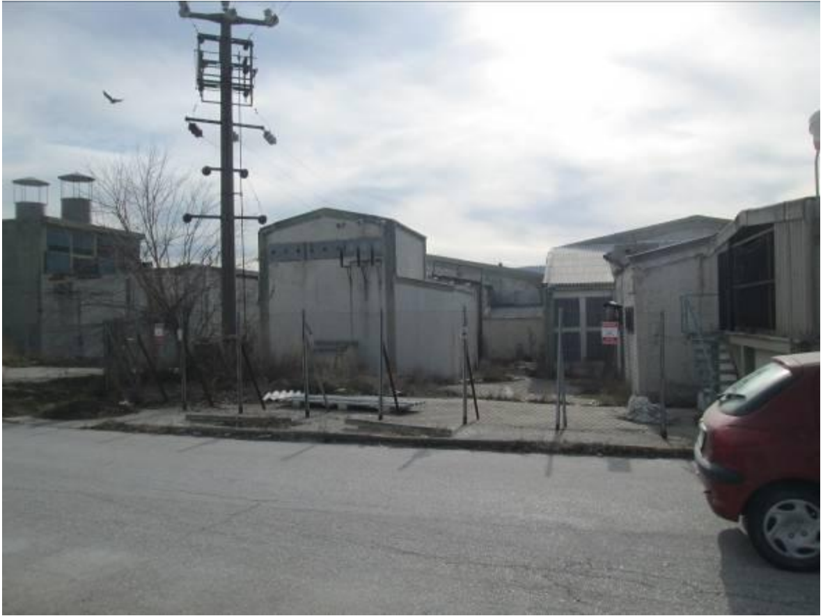
Trafo ve jeneratör binaları
